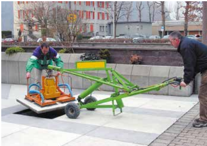
Plattenverlegegerät PRESTO
