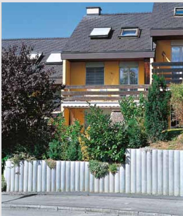
Beton-Palisaden als Hangsicherung.
