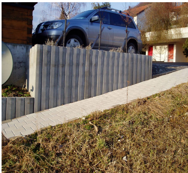
Bild 3: Rechteckige Palisaden als Böschungssicherung
