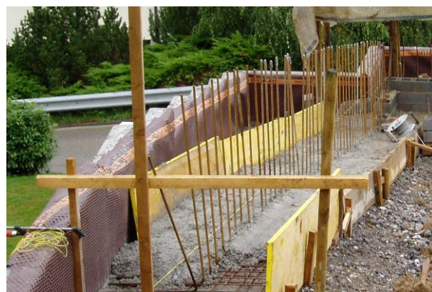
Bild 35: Fundament mit Anschlussbewehrung
