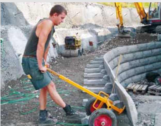
Einfaches Versetzen mit Handwagen
