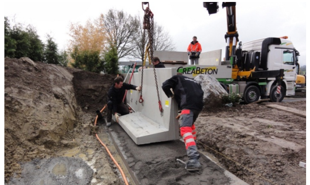
Bild 29: Versetzen der Winkelplatte auf ein Streifenfundament
