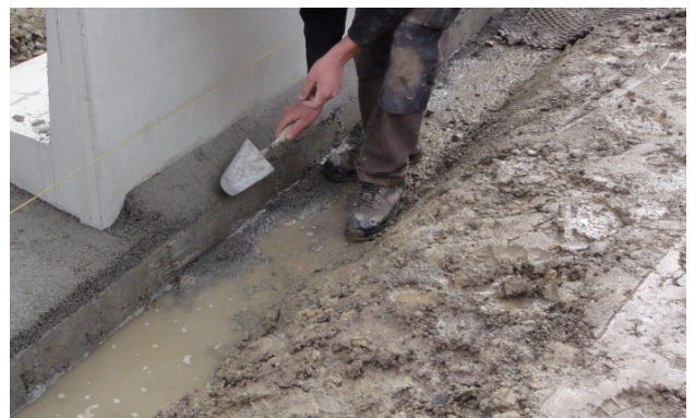
Bild 30: Erstellen der Fundamentnocken
