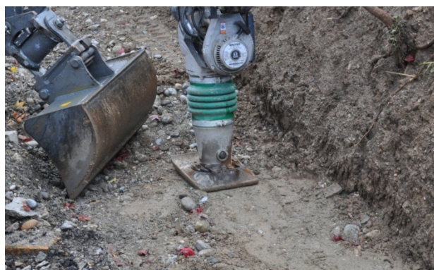
Bild 26: Erstellen der Sauberkeitsschicht
