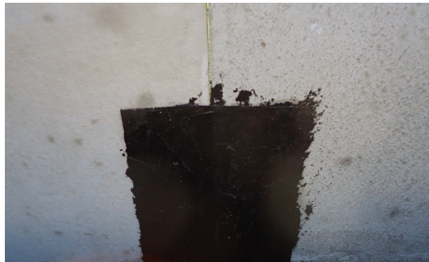
Bild 33: Abdichten der Fugen
