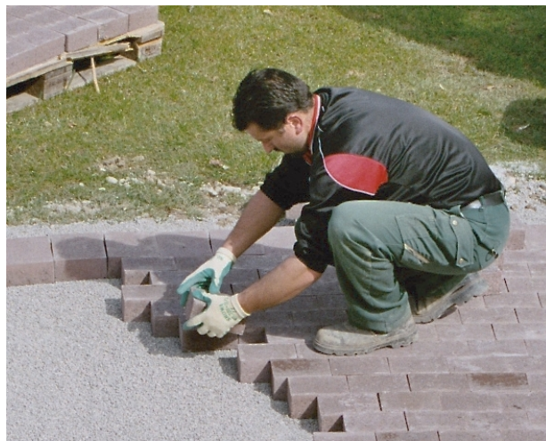
Bild 35: Verlegung der Steine von Hand
