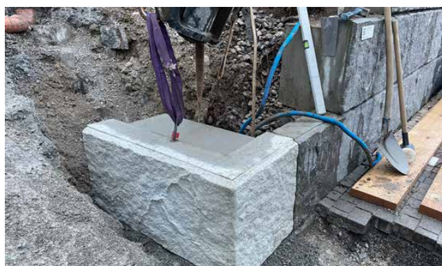
Illustration 22 : briques initiales avec semelle filante sans mortier-colle
