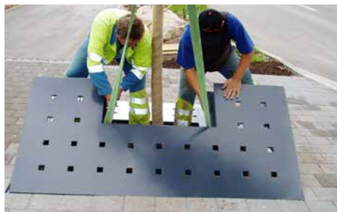
Versetzen der COPAL STEEL Stahlbaumscheibe
