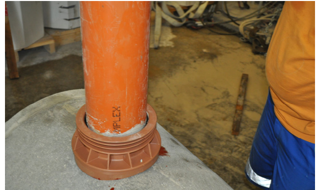
Bild 14: Anschlussrohr anschliessen
