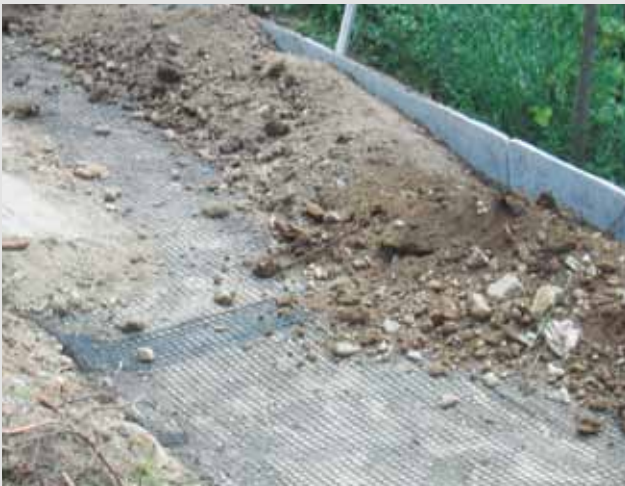
Verlegtes Geogitter
