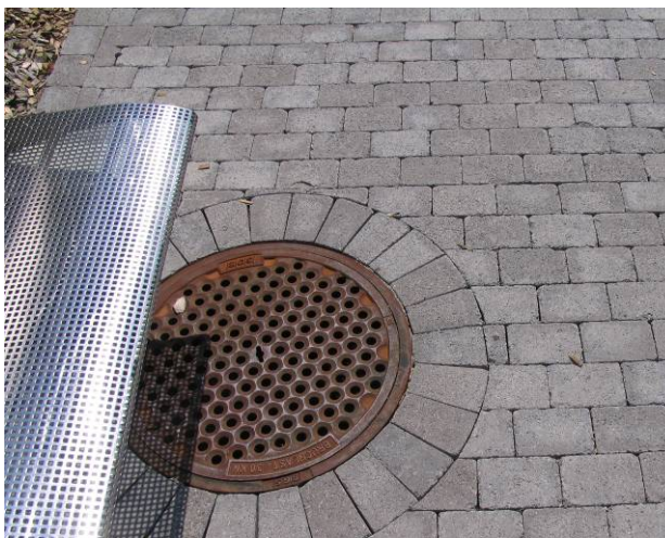
Bild 42: Anpassung bei Schachtabdeckung
