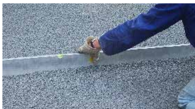
Figure 6 : nivellement du lit de pose
