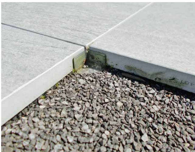
Figure 7 : pose des dalles de jardin en grès cérame sur le lit de pose
