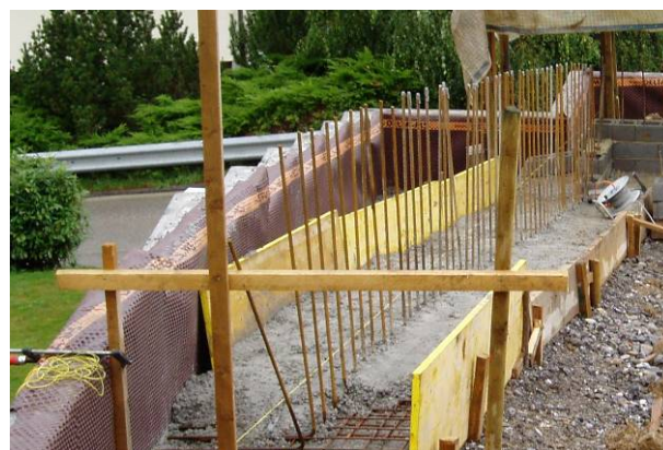
Bild 35: Fundament mit Anschlussbewehrung
