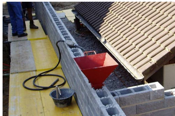
Bild 50: Einbringen von Füllbeton mit einem geeigneten Trichter
