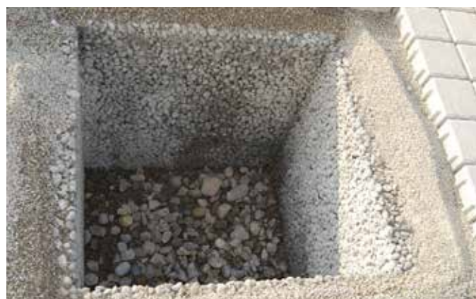
Erstellter Fundamentrahmen
