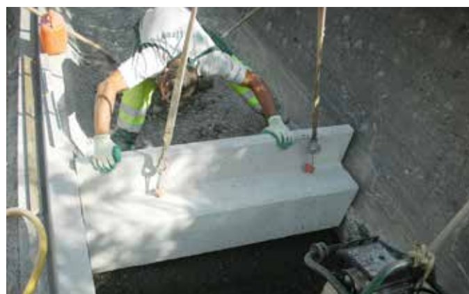
Versetzen des F+F Fertigfundamentes
