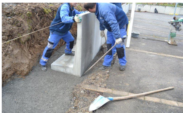
Bild 36: Richten der Winkelplatte
