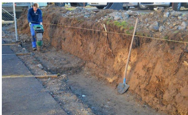
Bild 32: Erstellen der Sauberkeitsschicht
