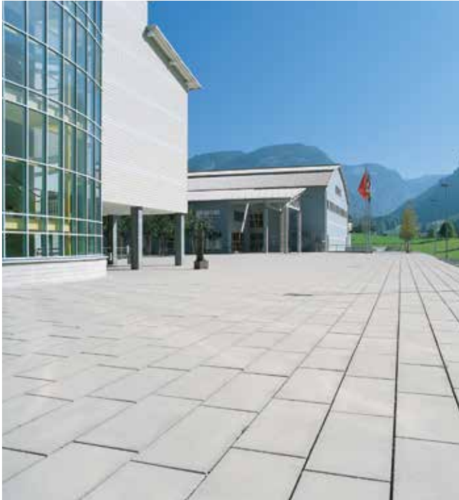
Öffentlicher Platz mit Vakuum-Platten
