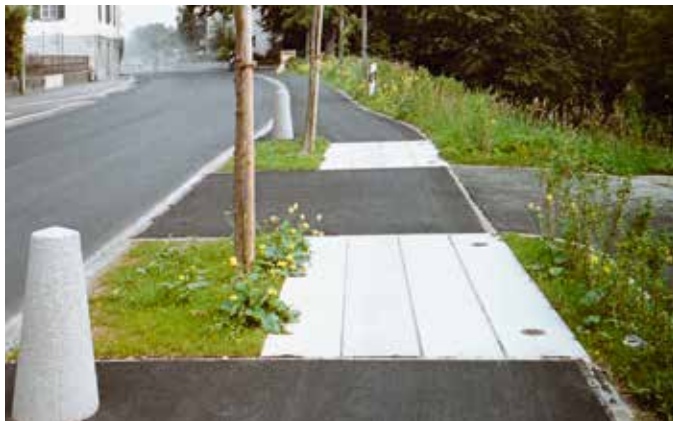
Wurzelbrücke mit Wehrsteinen als Anfahrtschutz
