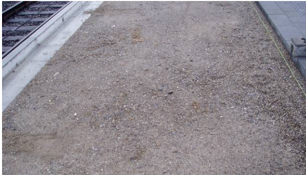
Bild 23: Eingebaute Fundamentsschicht
