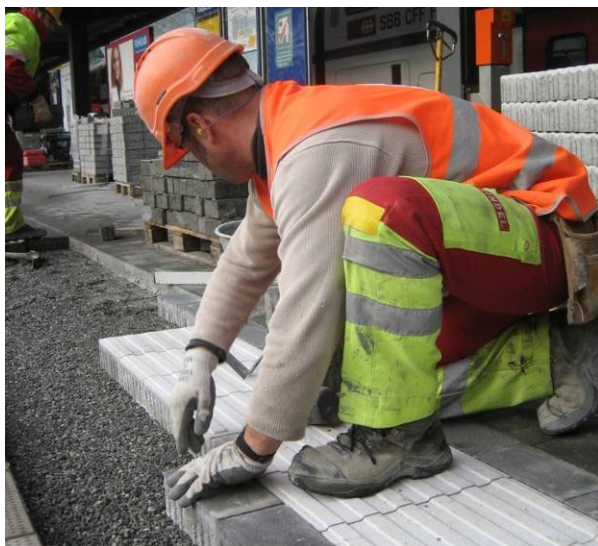
Bild 36: Verlegen der CARENA® Sicherheitsliniensteine H = 8 cm
