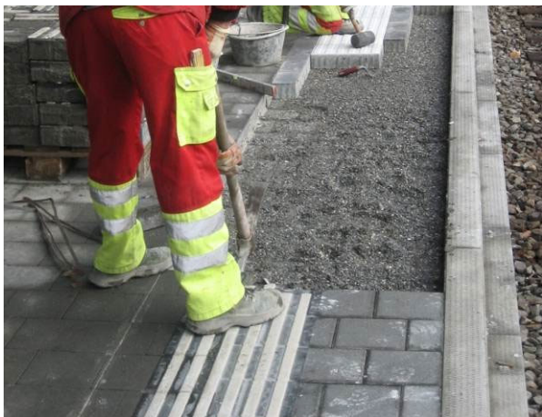
Bild 32: Herausnehmen der restlichen Steine
