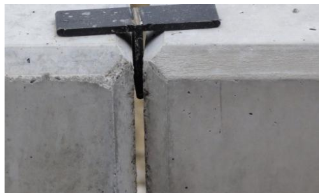
Bild 32: Optimale Fugen nach der Versetzung
