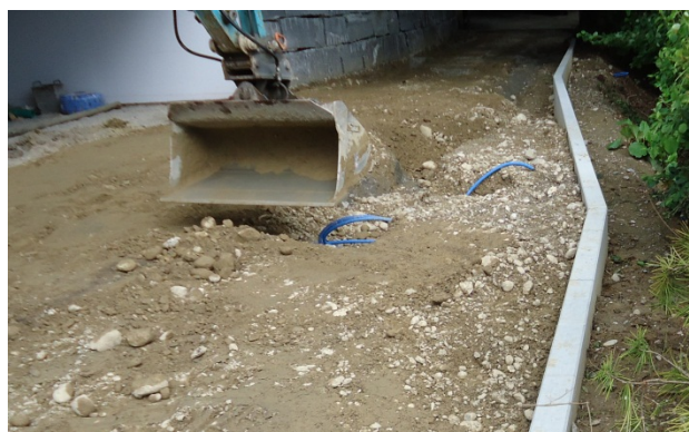
Bild 34: Lagenweises Einbringen von geeigneten Hinterfüllmaterial
