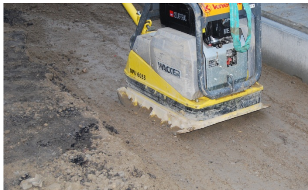
Bild 35: Verdichten nur mit leichten Verdichtungsgeräten
