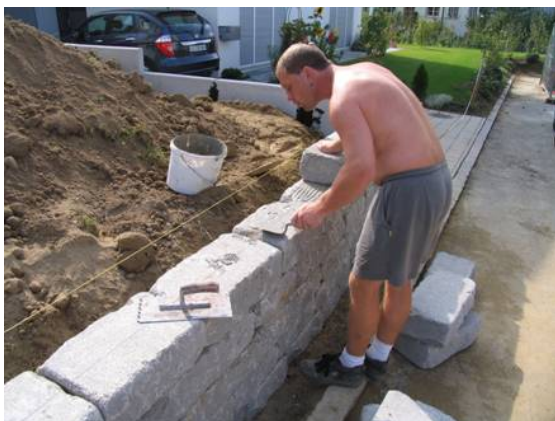
Bild 38: Mörteln der Fugen
