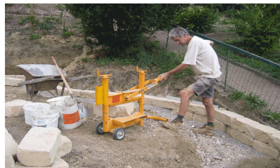
Bild 35: Arbeiten mit Steinspalter
