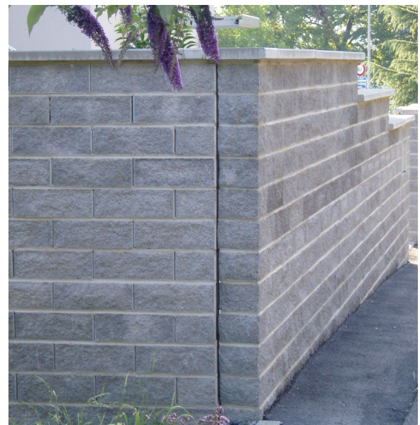
Bild 41: Dilationsfuge (Produktneutral)
