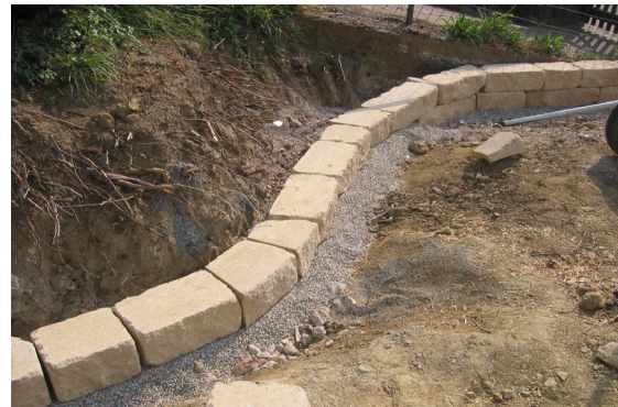
Bild 24: Versetzte erste Steinreihe in Kiesfundament
