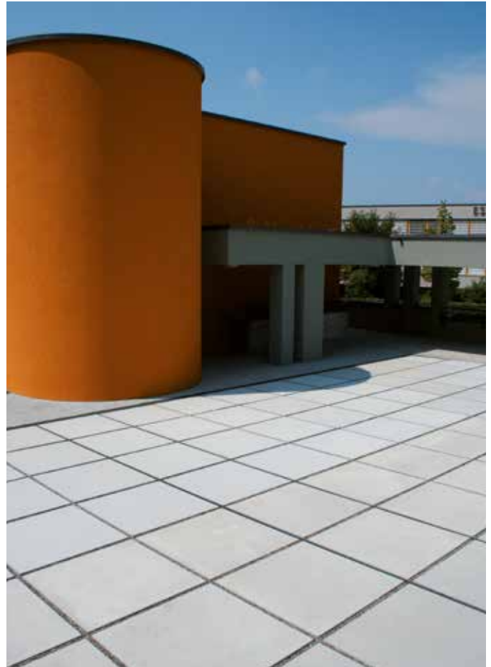
Optische Raumerweiterung mit grossflächigen Platten
