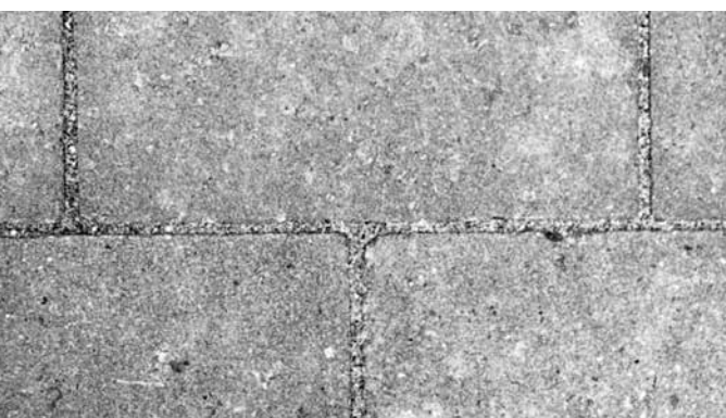
Wirksame Pflasterdecke durch funktionsfähige Fugen
