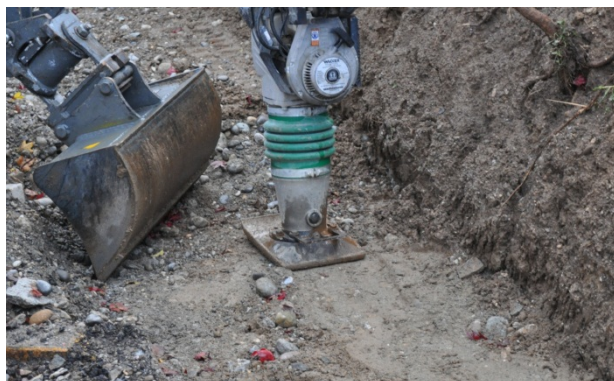
Bild 26: Erstellen der Sauberkeitsschicht
