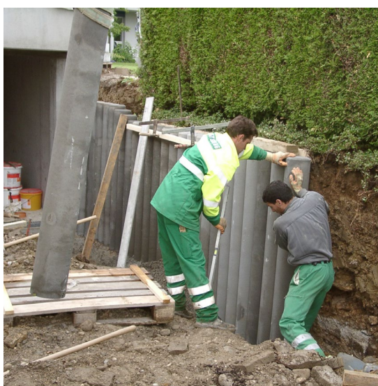
Bild 12: Versetzen und Richten von Palisaden
