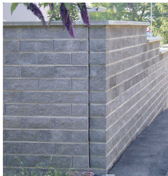
Bild 41: Dilatationsfuge (Produktneutral)
