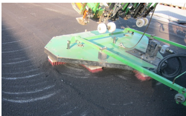
Bild 27: Maschinelles Einbringen des ECOPREC®-Fugenmaterials
