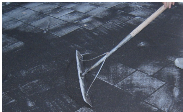
Bild 28: Einbringen des Fugenmaterials von Hand
