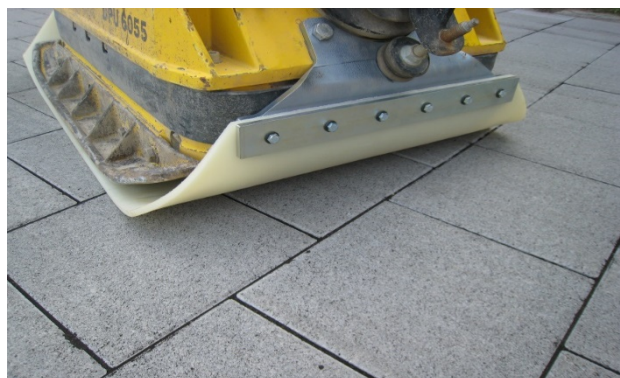
Bild 29: Abrütteln der Pflasterdecke
