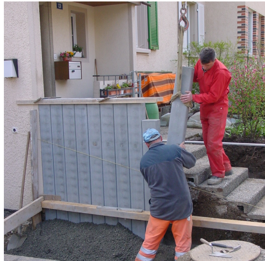
Bild 12: Einbau Palisaden
