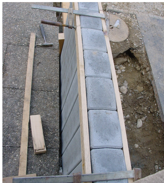
Bild 13: Gesicherte Palisaden
