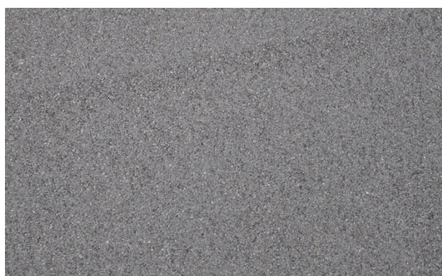
Bild 21: Kontrolle der Oberflächenbeschaffenheit
