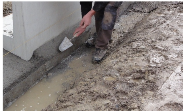
Bild 30: Erstellen der Fundamentnocken
