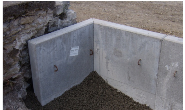
Bild 31: Versetzte Eckelemente
