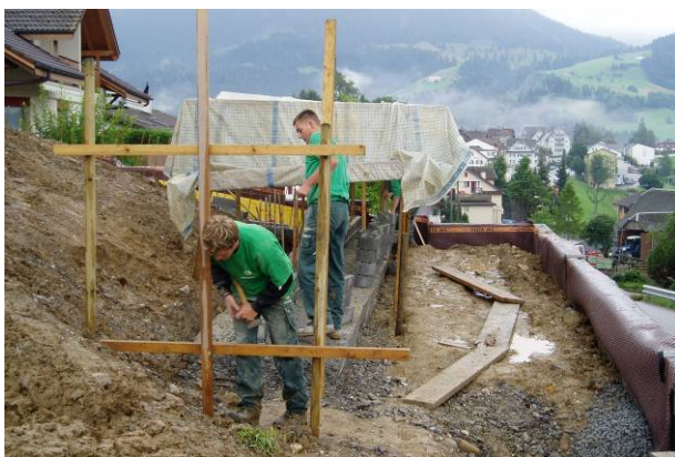
Bild 34: Setzen einer Richtschnur
