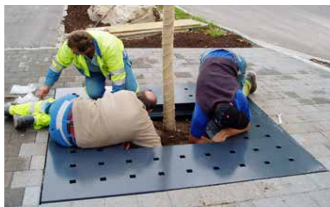
Montieren der Verbindungsschrauben
