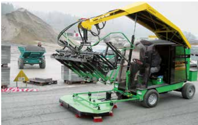
Einfaches Einsanden oder Einsplitten mit der gleichen Maschine
