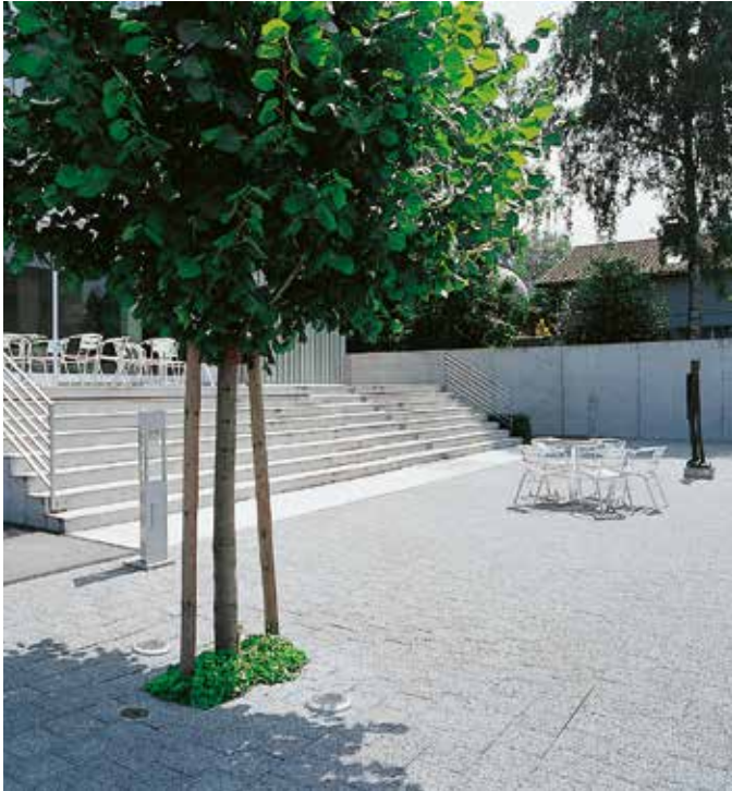
Innenhof mit Sickerstein
