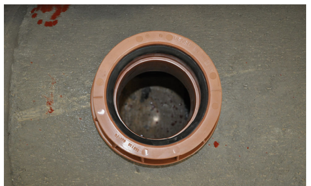
Bild 13: Keilgleitdichtung und Spitzende mit Gleitmittel einschmieren
