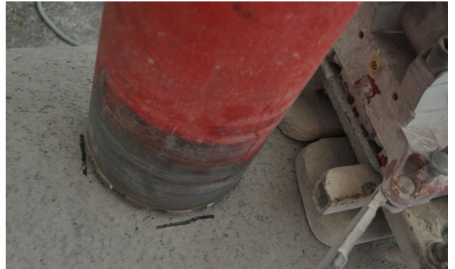
Bild 6: Korrekt montiertes Kernbohrgerät
