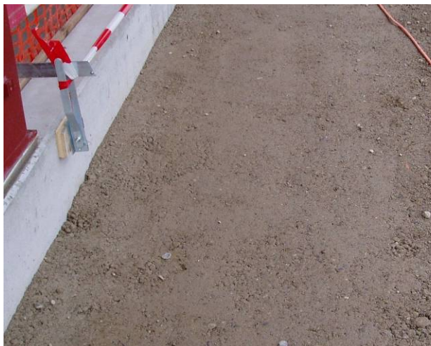
Bild 32: Eingebaute verdichtete Fundationsschicht
