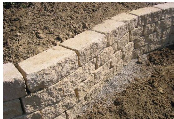
Bild 28: Kurvengbildung mit geraden Steinen
