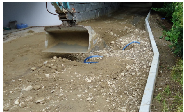
Bild 34: Lagenweises Einbringen von geeigneten Hinterfüllmaterial
