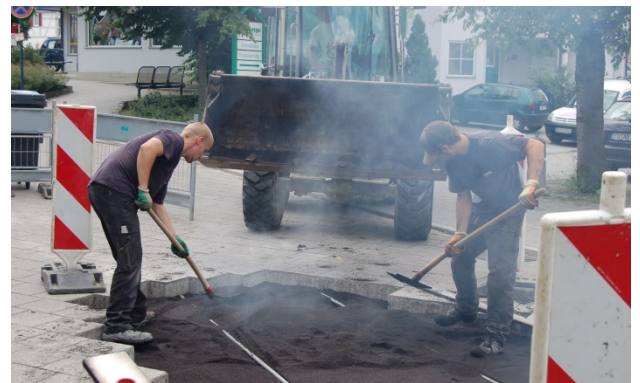
Bild 17: Mischgut muss gesetzt werden
