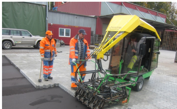
Bild 25: Maschinelle Verlegung
