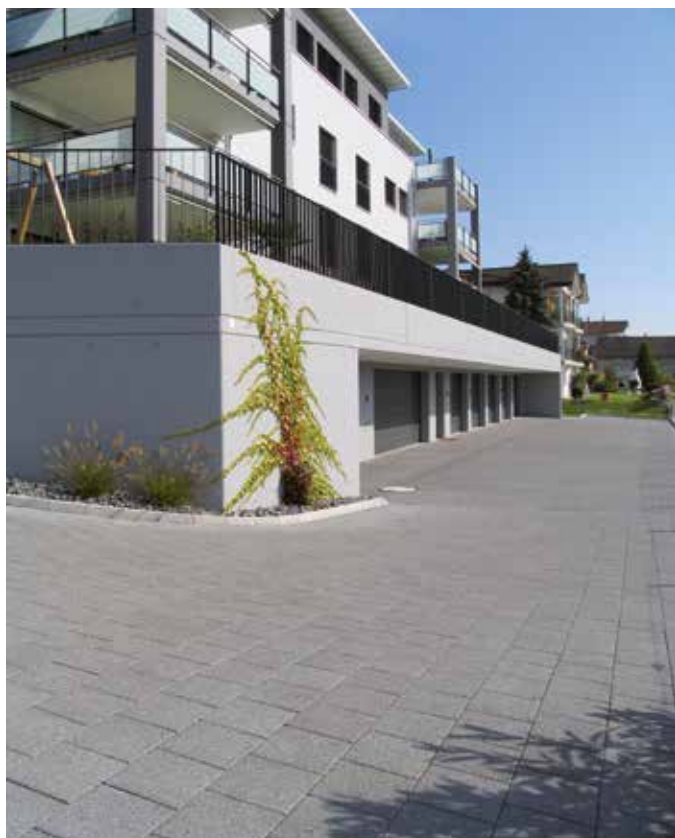
Versickerung durch Sickerstein
