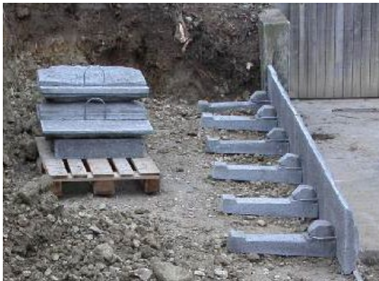
Bild 18: Verlegte Frontplatte mit Normalanker
