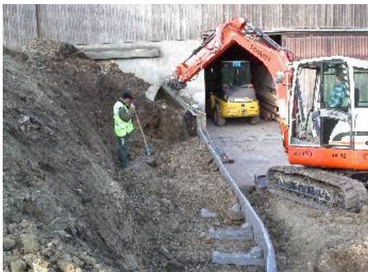
Bild 20: Hinterfüllen der ersten 20 cm
