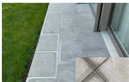
Efflorescence de calcaire sous forme de dépôt de cristaux blancs
