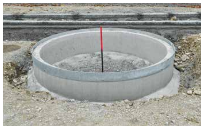
Montierter Stahlleinbaurahmen mit Bolzenanker
