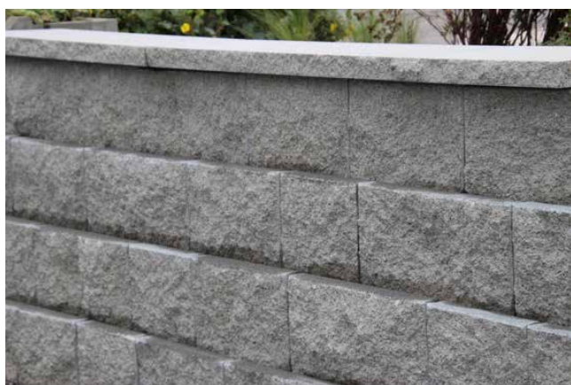
Illustration 1 : structure fermée avec couvertines
