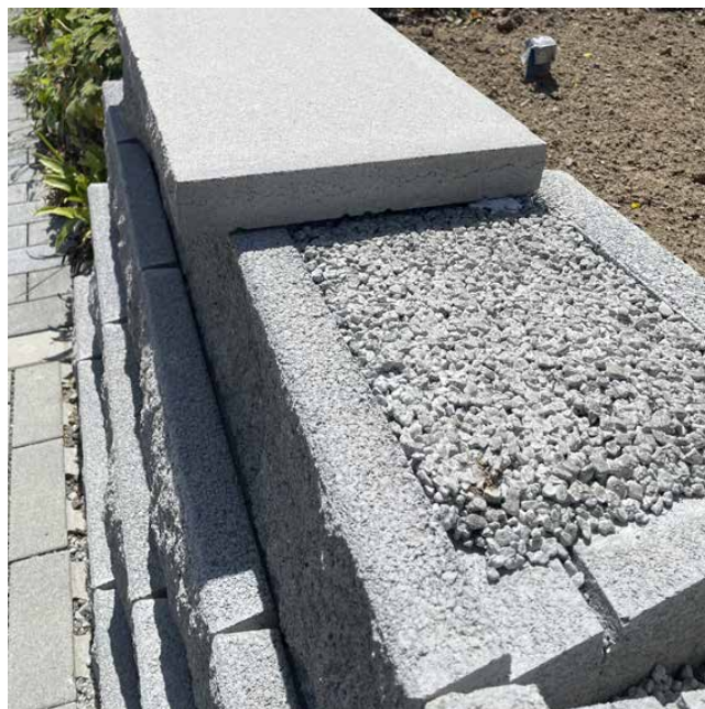
Illustration 19 : pose de plaques de couverture
