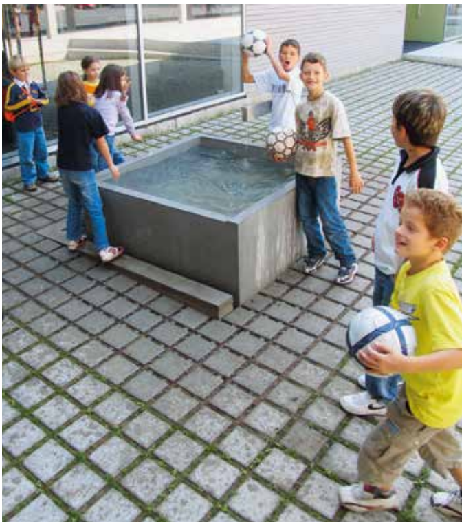
Pausenplatz mit Rasenfugenstein
