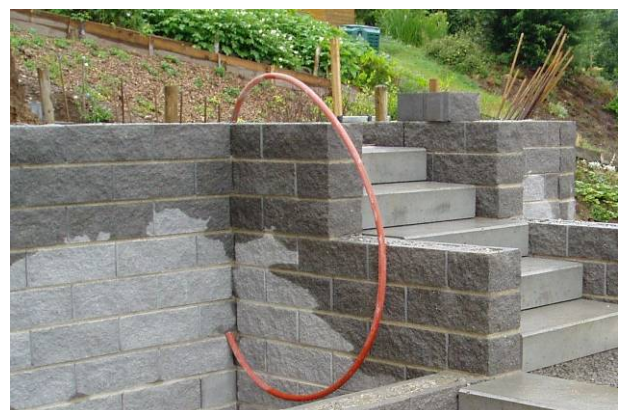
Bild 40: Einlegen der Leerrohre
