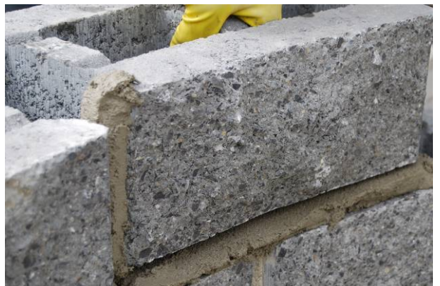
Bild 43: Versetzen des Mauersteines auf die Mörtelschicht
