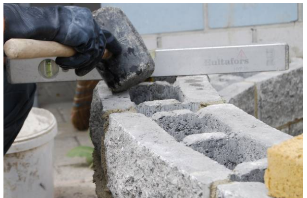
Bild 44: Richten und anklopfen des versetzten Spaltsteines
