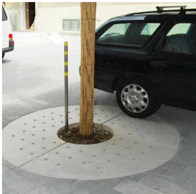
TREETUB Baumwurzelraumschutz mit Betonabdeckung
