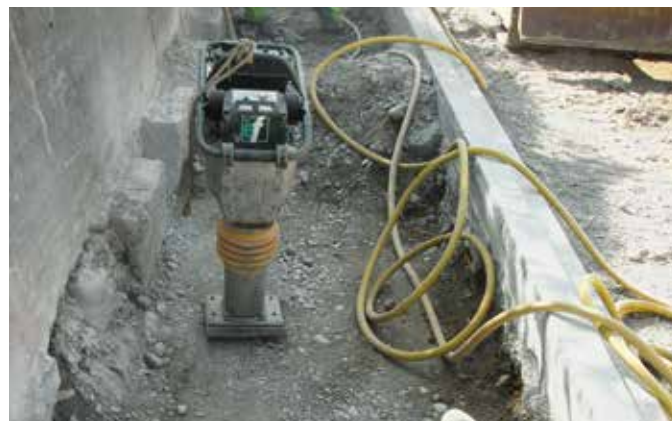
Sohle für die Versetzung der Fundamente
