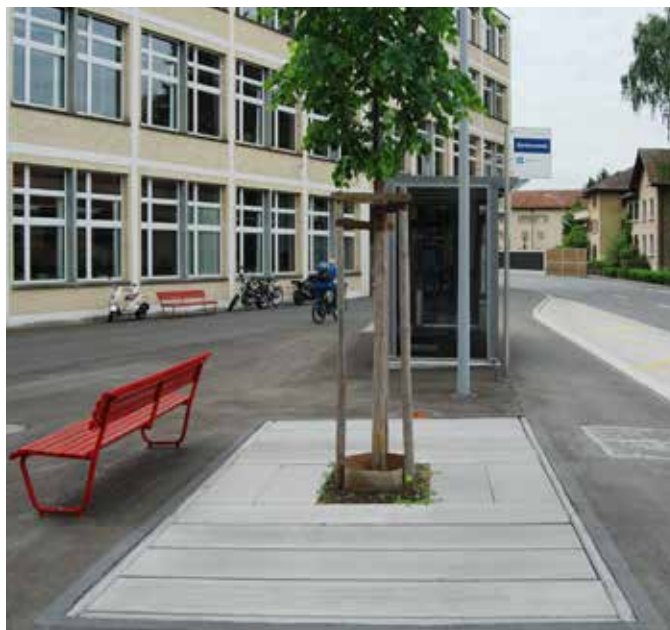
F+F Baumwurzelraumschutz, anthrazit eingefärbt
