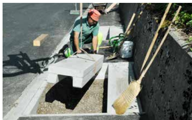
Versetzen der F+F Abdeckelemente
