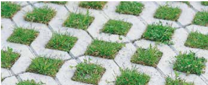
Versickerung durch eingelassene Kammern (Rasengittersteine)
