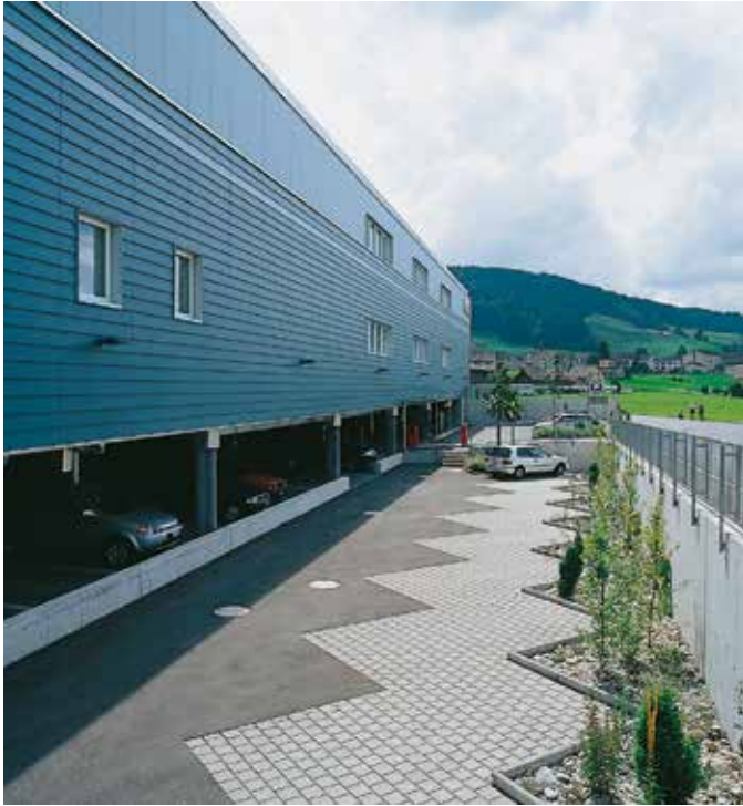
Versiegelte Fläche, kombiniert mit Versickerung
