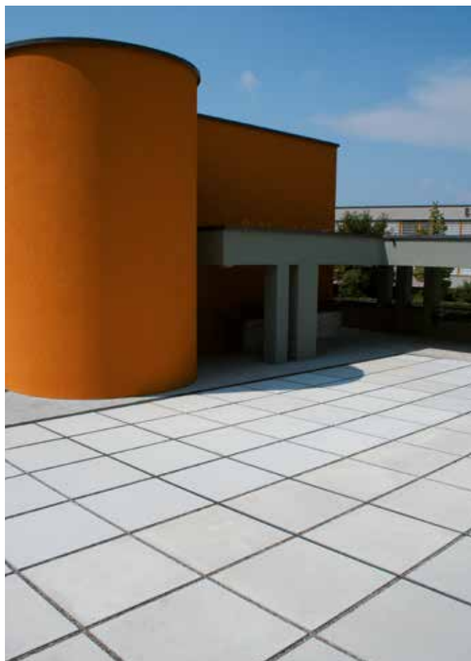
Optische Raumerweiterung mit grossflächigen Platten
