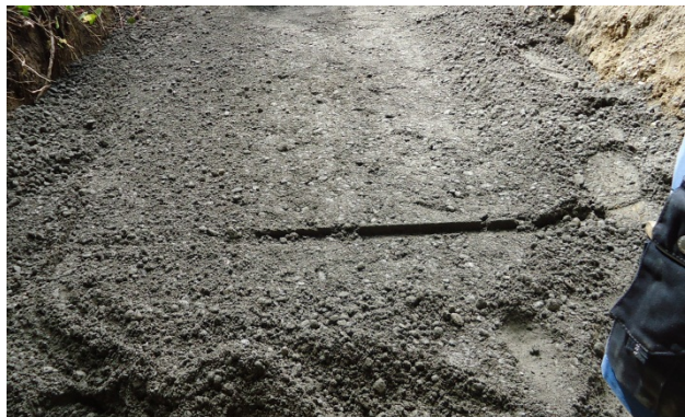
Bild 23: Erstellen des Streifenfundamentes
