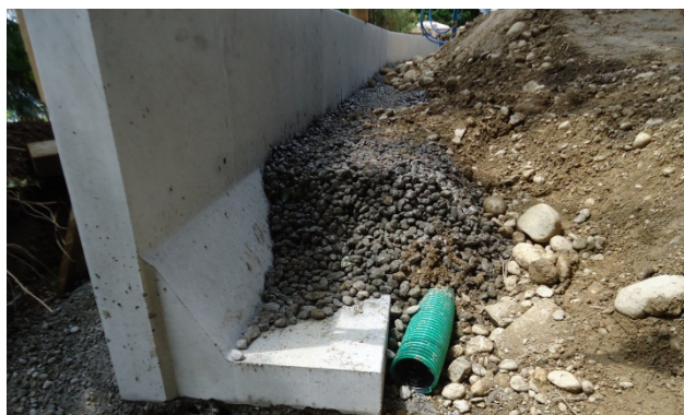
Bild 24: Einbau einer Sickerleitung
